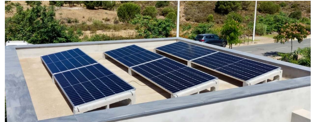
► Instalación de autoconsumo sobre cubierta plana en vivienda unifamiliar en Ayamonte, Huelva
