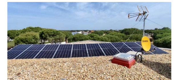
► Instalación de autoconsumo sobre cubierta plana en vivienda unifamiliar en Ayamonte, Huelva
