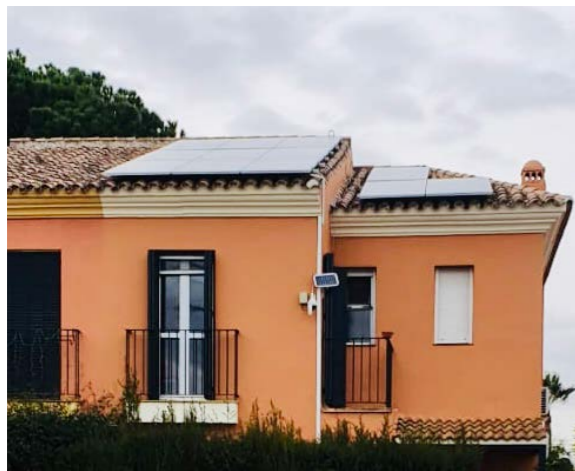
► Instalación de autoconsumo fotovoltaico en vivienda unifamiliar en el Aljarafe, Sevilla.
